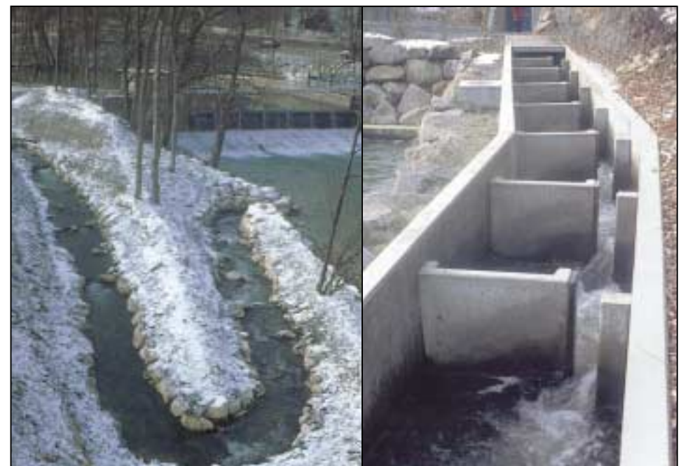
Umgehungsrinne (links) und Schlitzpass (rechts) an der Birs
